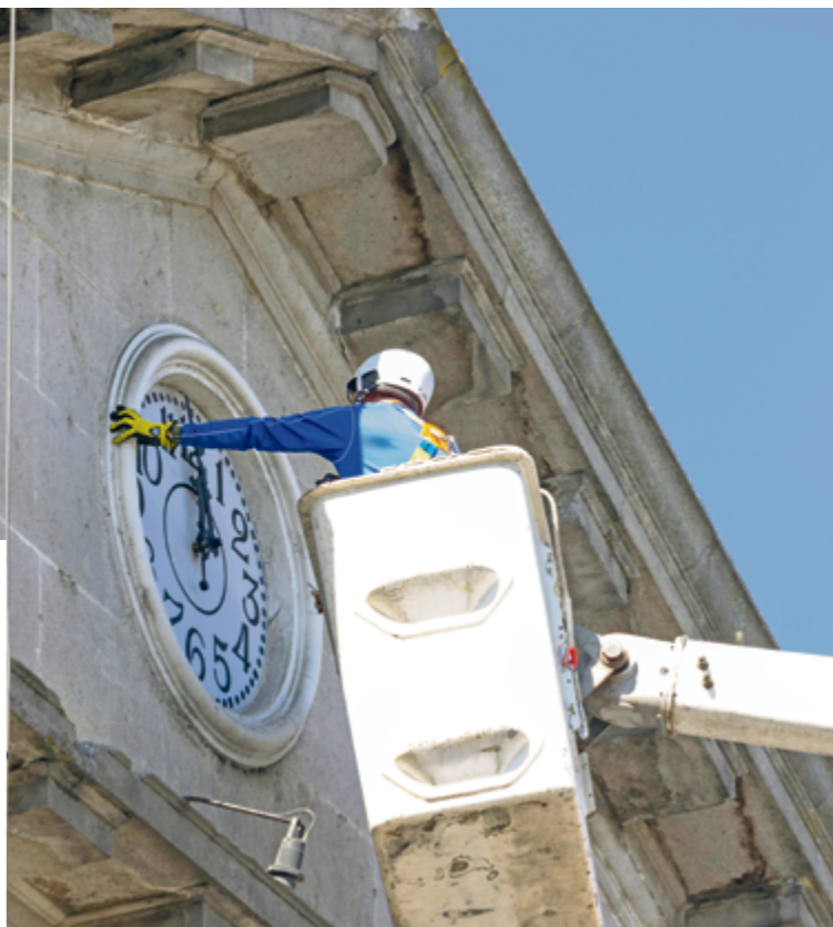
Guido Velásquez revisó engranajes, alineó piezas y ajustó el mecanismo para recuperar su precisión original.
